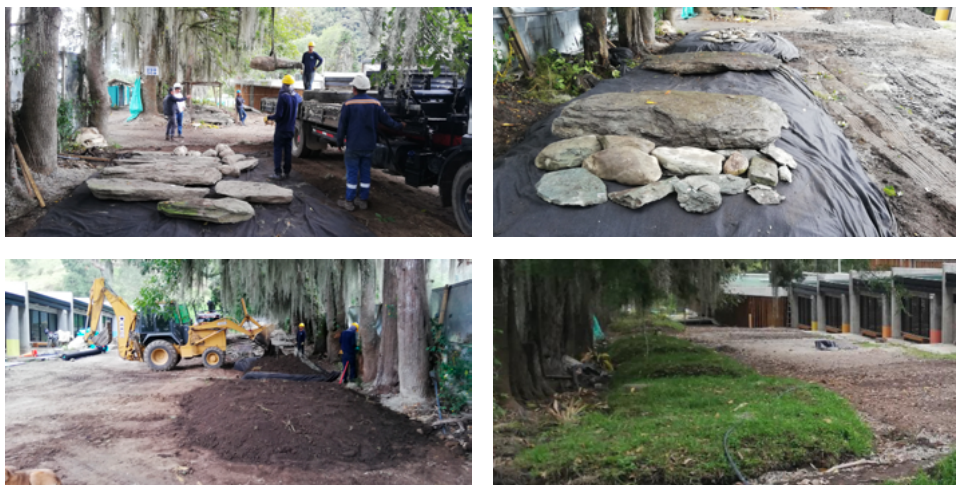
Figuras 21 a 24. Proceso de re-enterramiento de siete estructuras en el costado norte del predio. La Leona, Cajamarca
