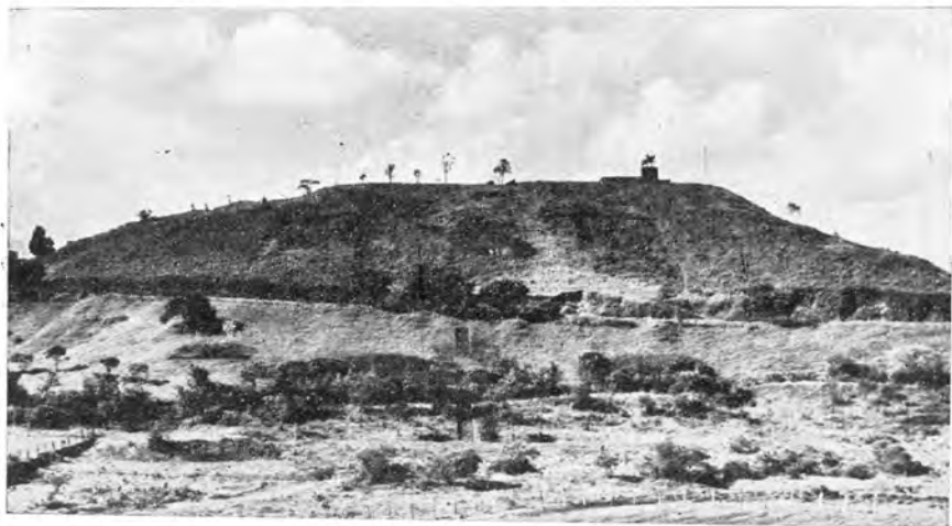
a) Aspecto del declive norte de la pirámide, donde se aprecian las trincheras excavadas.
