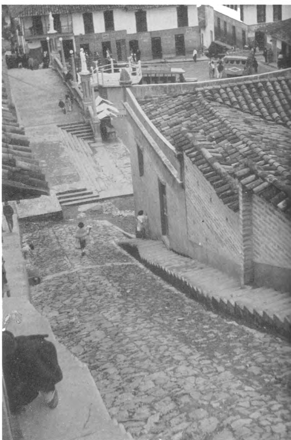
Plaza y calle de un típico pueblo cafetero antioqueño, construido sobre la cuchilla de alguna cordillera. Las pendientes de algunas calles son tan fuertes, que los andenes se construyen en forma de gradería. Nótese el kisko localizado en la plaza
