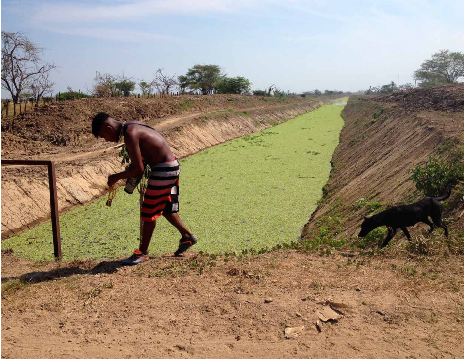
Figura 2. Canal de drenaje, Manatí, Atlántico. Mayo de 2013
