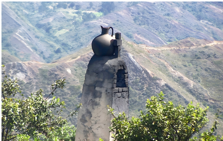
Figura 2. Copa de la chimenea del horno
