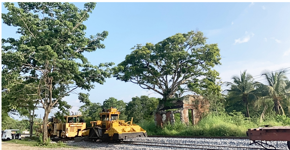
Figura 8. Antigua boletería en Estación Sarabia, Guichicovi, junto a maquinaria para trabajos de rehabilitación, agosto de 2023
