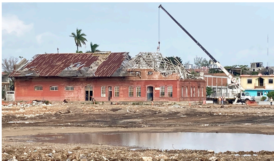
Figura 2. Desmantelamiento de los talleres ferrocarrileros de Matías Romero, Oaxaca, agosto de 2023
