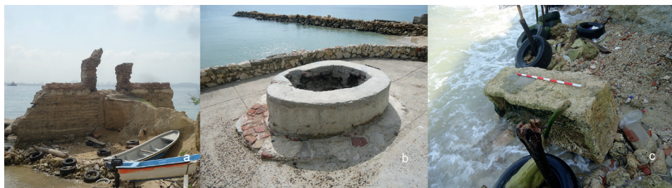
Figura 2. Infraestructura asociada al tratamiento del agua en el tejear de San Bernabé: a) aljibe, b) pozo y c) abrevadero
