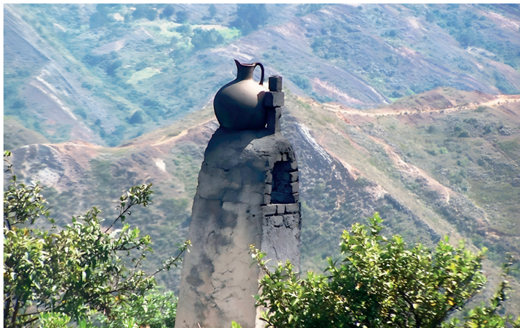
Figura 2. Copa de la chimenea del horno
