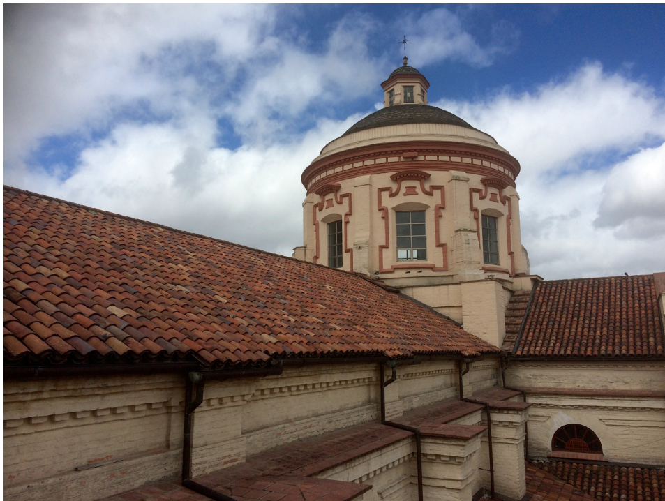
Figura 2. Vista general de la iglesia de San Ignacio después de su restauración
