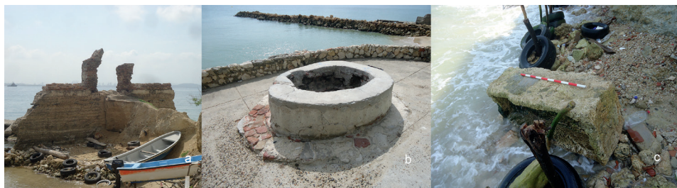
Figura 2. Infraestructura asociada al tratamiento del agua en el tejear de San Bernabé: a) aljibe, b) pozo y c) abrevadero
